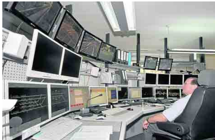
Abb. 4.1: Leitzentrale für die Tram-Überwachung als Beispiel für eine schwer zu durchschauende Arbeitsumgebung [Cam]
