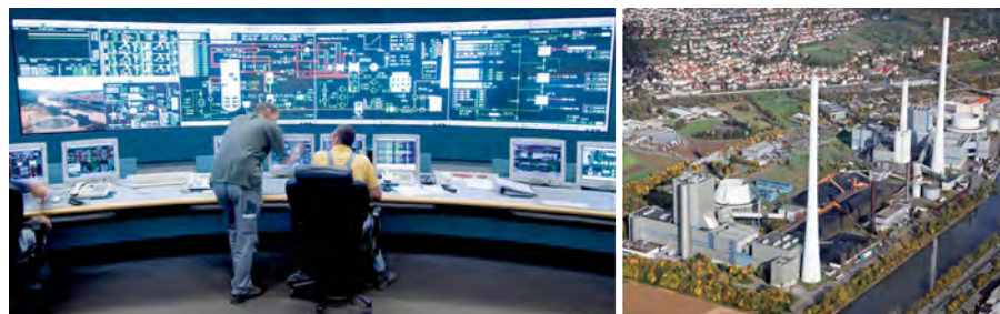
Abbildung 2: Heizkraftwerk Altbach/Deizisau; Leitwarte (links) und Anlage (rechts) (EnBW Energie Baden-Württemberg AG, 2010)
